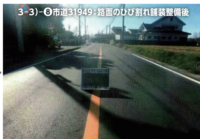
3-3)-⑧市道31949:路面のひび割れ舗装整備後
