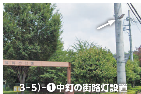
3-5)-①中釘の街路灯新設
